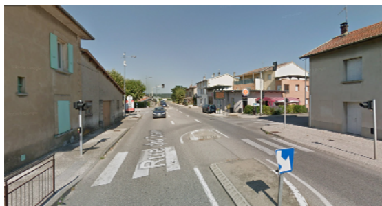
Carrefour RD5232 et RD574a au centre village
